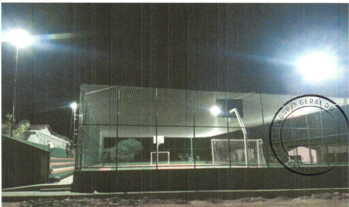
FOTO 08- EXECUÇÃO DA ILUMINAÇÃO DA QUADRA
