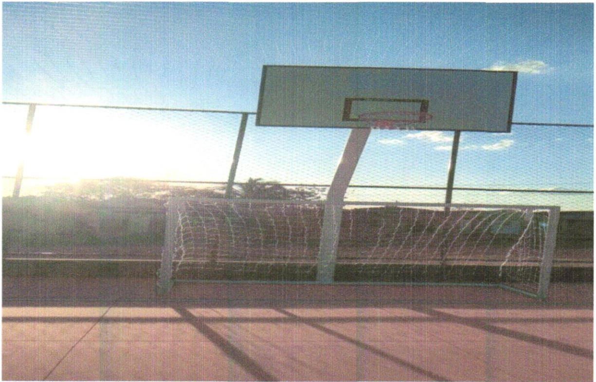
Foto 09- EXECUÇÃO DA REDE DE PROTEÇÃO, TABELA DE BASQUETE E REDE DE PROTEÇÃO.
