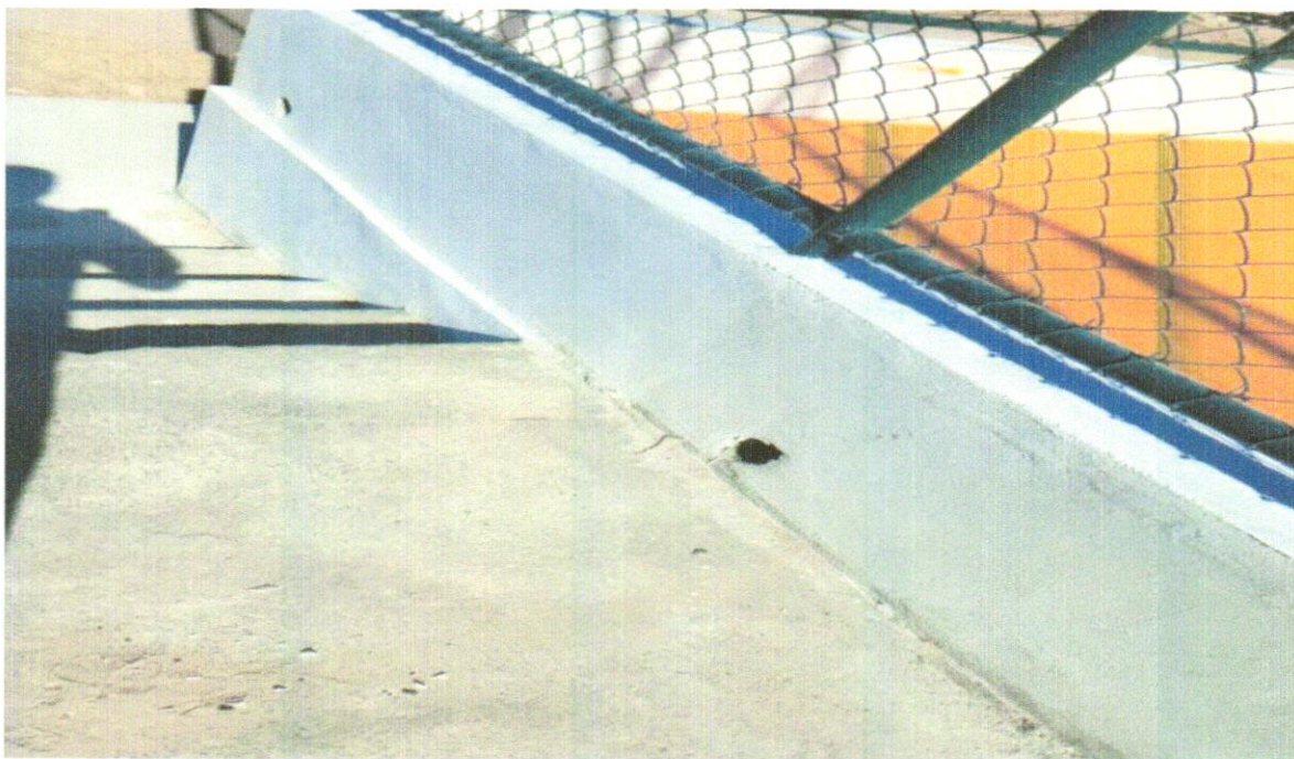
FOTO 11 - APLICAÇÃO DE SELADOR.
