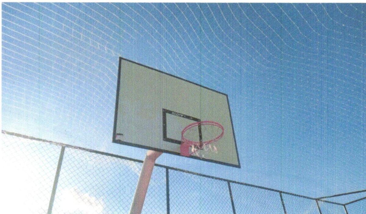
FOTO 5: EXECUÇÃO DA TABELA DE BASQUETE E TELA DE PROTEÇÃO
