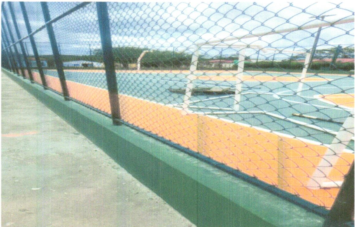
FOTO 13- EXECUÇÃO DE PINTURA DA PAREDE DO ALAMBRADO, DAS TRAVES E DO POSTE DA TABELA DO BASQUETE.
