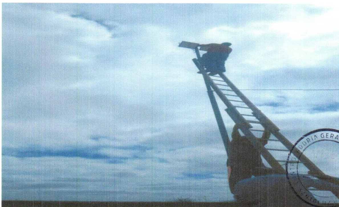
FOTO 12- EXECUÇÃO DAS LUMINÁRIAS.
