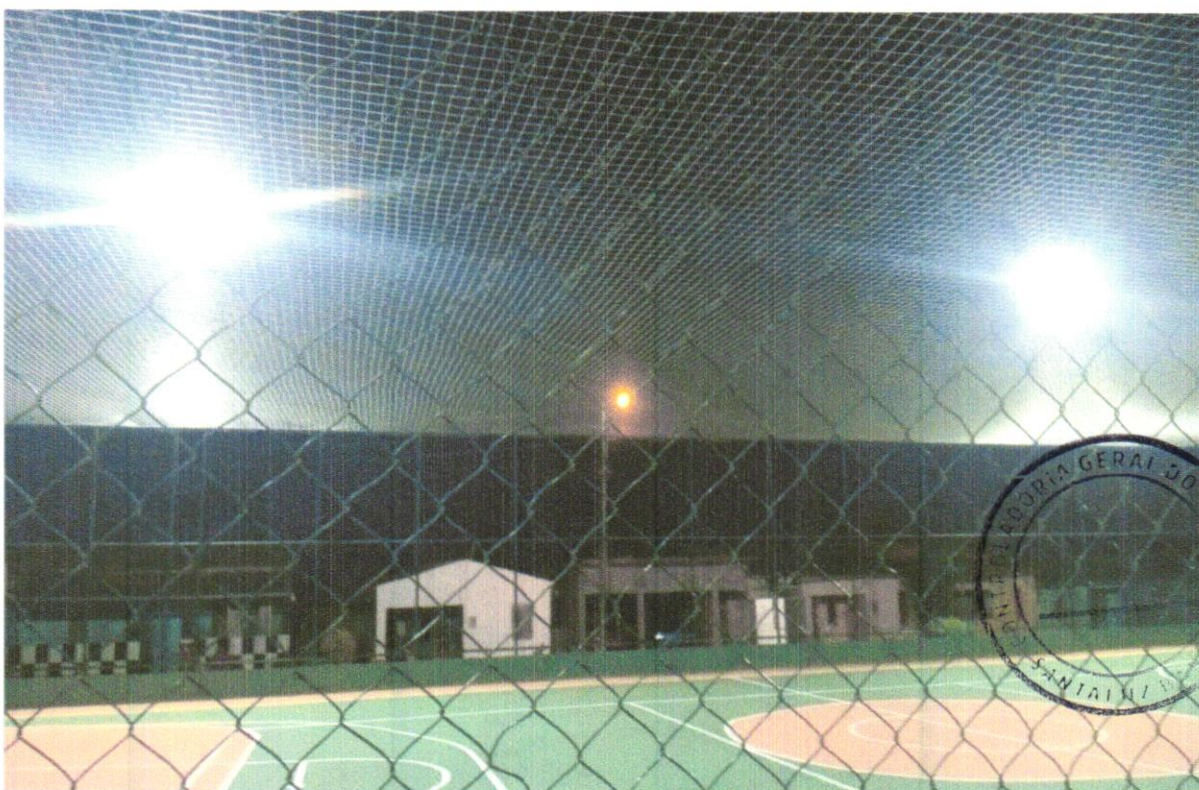
FOTO 6: EXECUÇÃO DA ILUMINAÇÃO DA QUADRA
