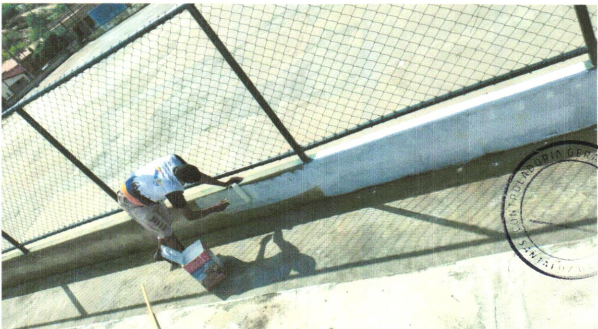
FOTO 10- APLICAÇÃO DE SELADOR.
